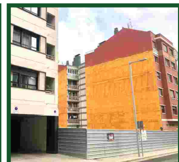
Realizado el derribo.
