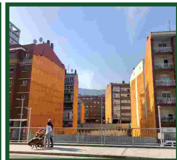
Realizado el derribo.
